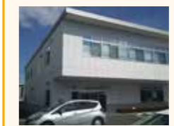
中央地区管理センター
